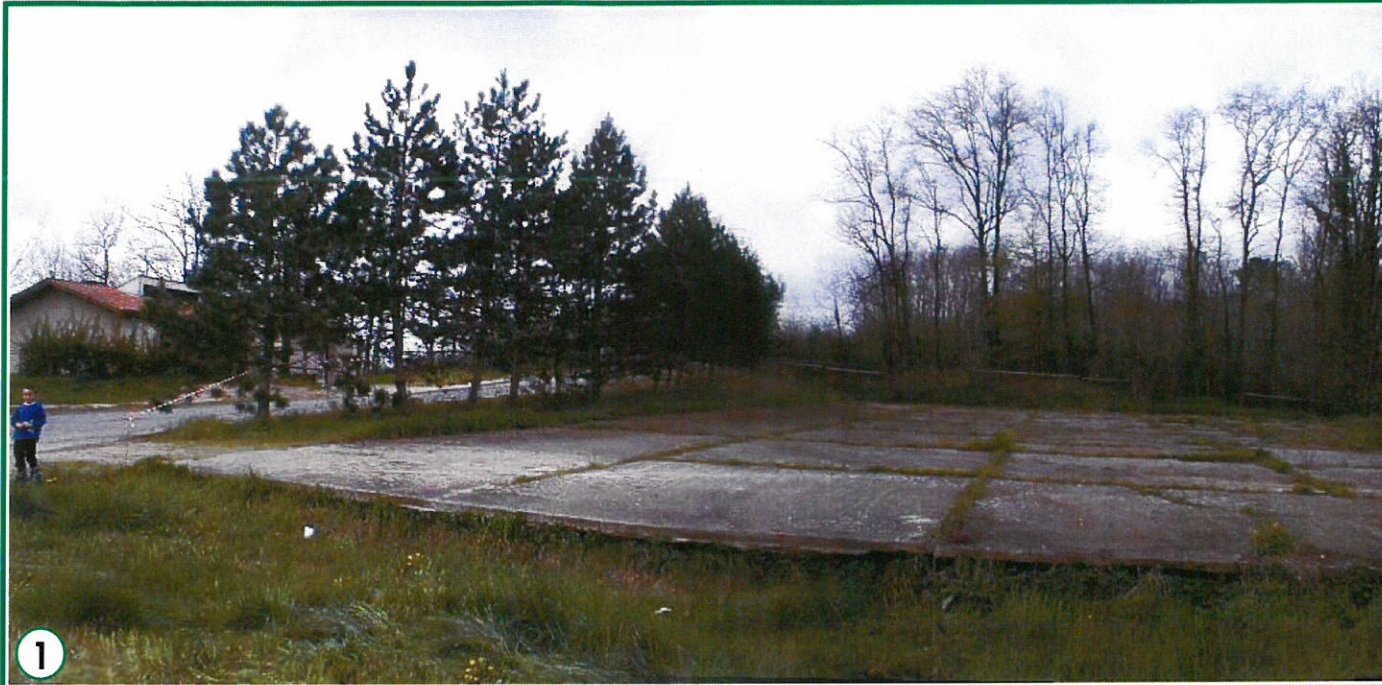
Entrée du site, dépôt recouvert par la dalle bétonnée de l'aire de stockage de compost.
